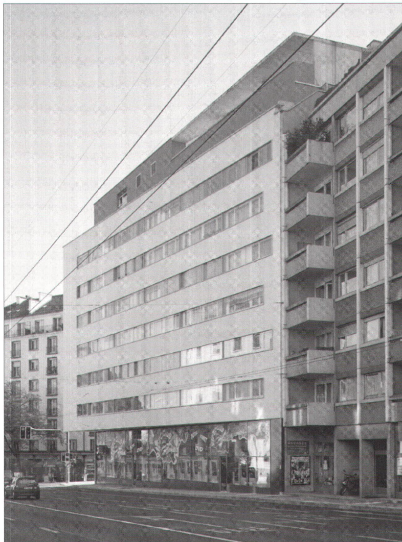
Vue côté rue de Lyon
