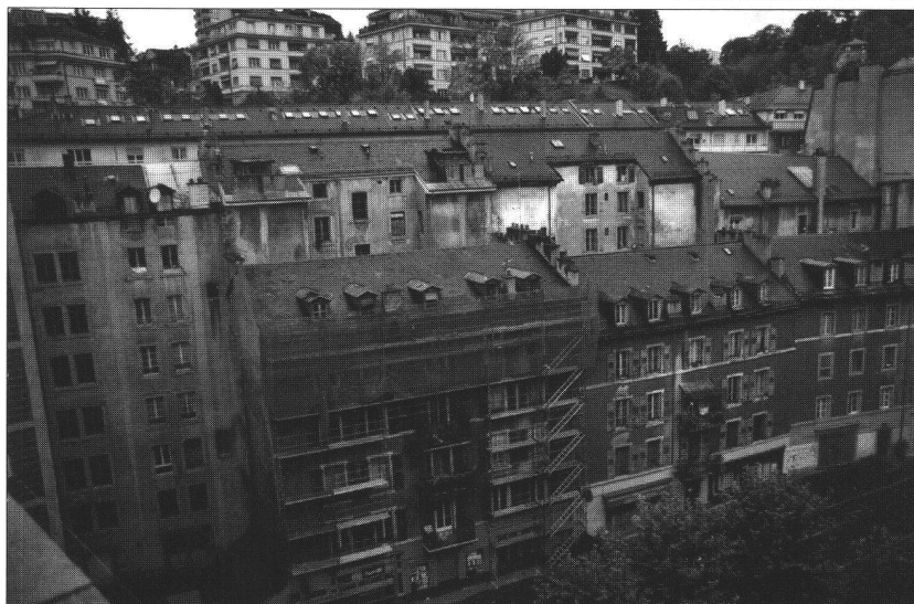
Photo aérienne de l'îlot
