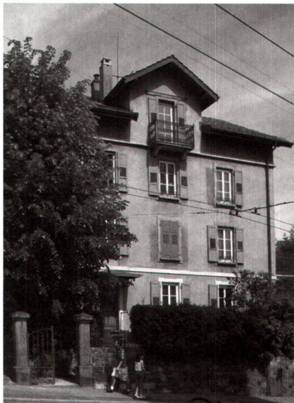
La maison acquise par la coopérative OVAL64 à Lausanne, vue depuis la rue du Valentin.
