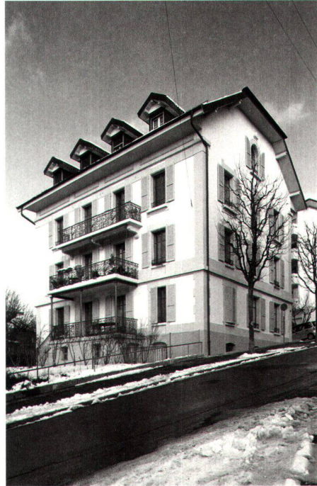
Vue extérieure après les travaux
