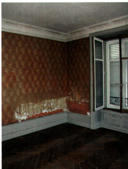
Une chambre avant les travaux.
