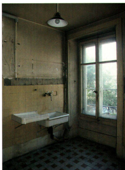
Une cuisine avant les travaux
