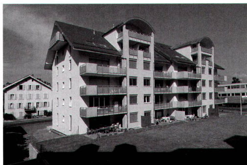
Immeuble de 22 logements sis à la rue de l'Industrie 20-22 à Bussigny, construit en 2003-04.
