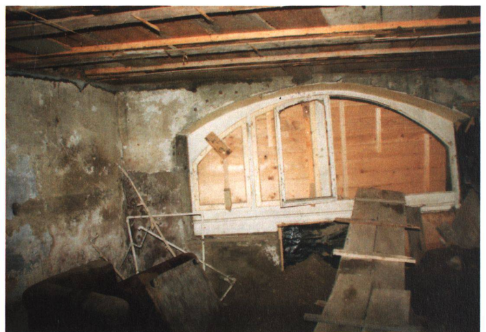
Une chambre côté rue, avant, pendant et après les transformations de l'intérieur et de l'extérieur
