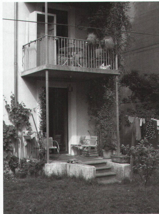
Vue sur un balcon donnant sur le jardin, avec la porte vitrée ouvrant sur la salle commune du rez
