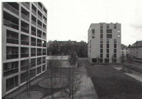
Deux des sept bâtiments de huit étages sont achevés.
