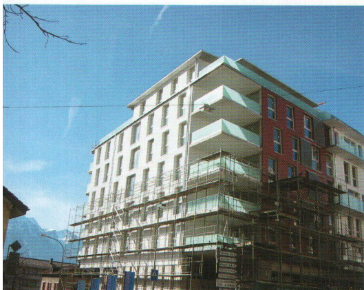
L'immeuble en construction à Clarens (VD).
