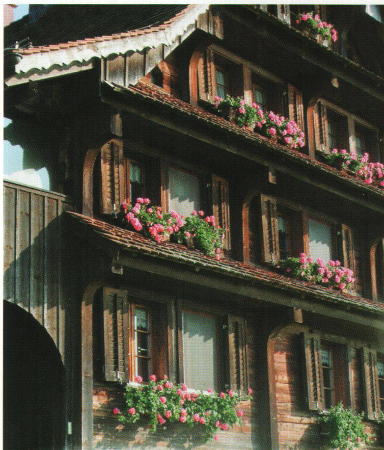
Solution historique pour protéger la fenêtre des intempéries.
