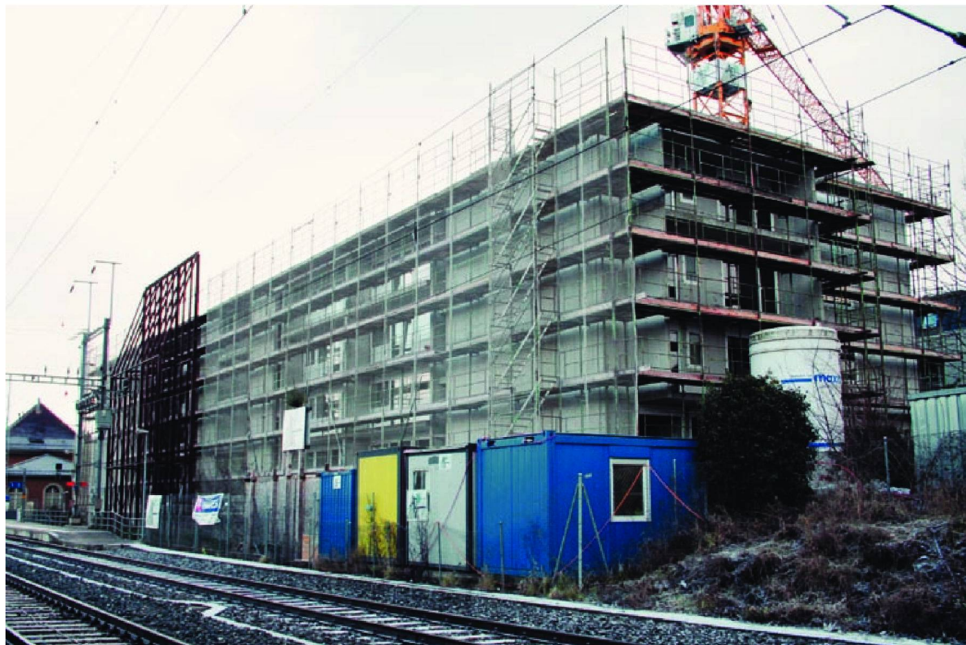
L'immeuble en construction à deux pas des quais de la gare de Morges.
