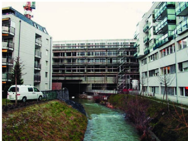
L'immeuble fait pont au-dessus de la rivière.
