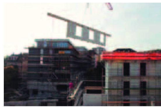
Les immeubles en chantier à l'Avenue Victor-Ruffy.
