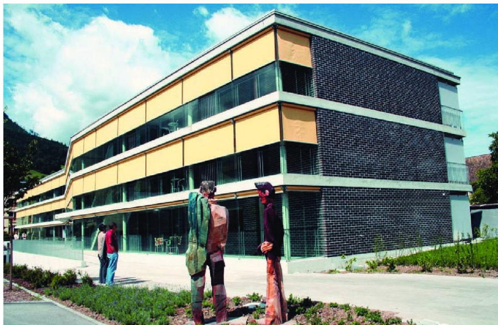
Briques et verre caractérisent la nouvelle construction de la SCH Alterswohnungen Mels, et l'art n'est pas en reste, avec les sculptures en bois de Peter Leisinger. © wohnen
