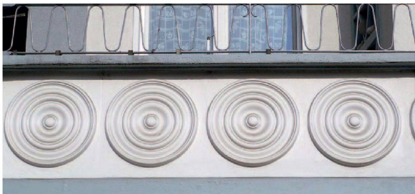
Éléments de décoration sur les balcons situés au-dessus des entrées d'immeuble.
