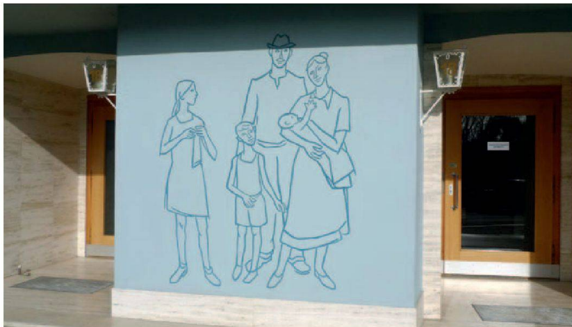
Sgraffite de Heinz Schwartz après rénovation.
