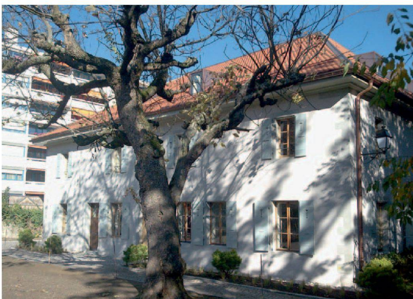
Clos Voltaire: façade sud-est après rénovation.
