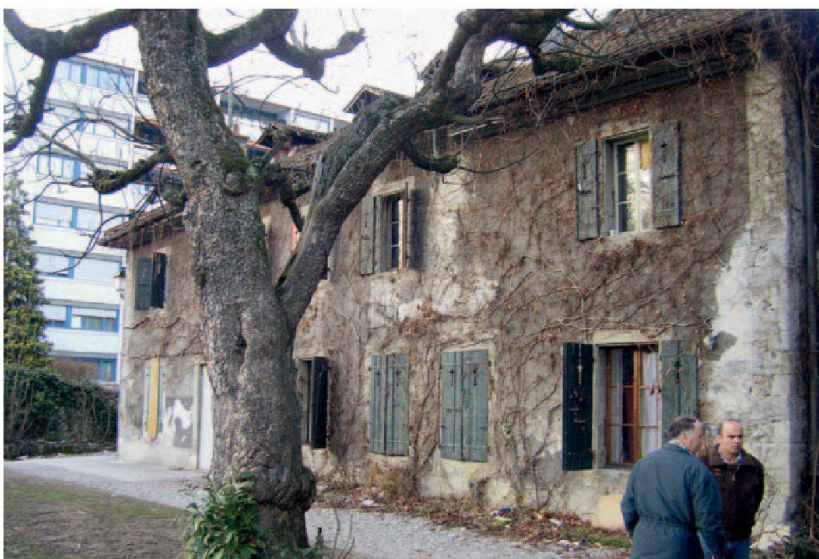
Clos Voltaire: façade sud-est avant rénovation.
