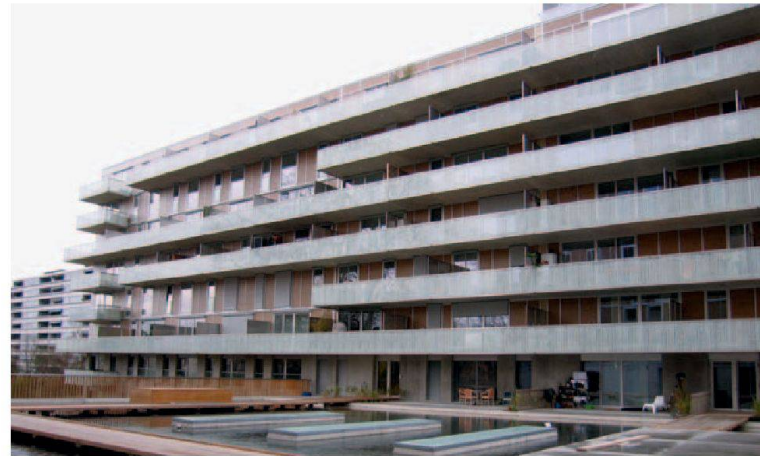
Le bâtiment de la SCHG et Rhône-Arve donnant sur le plan d'eau et les passerelles menant au bâtiment de la CODHA, en face.
