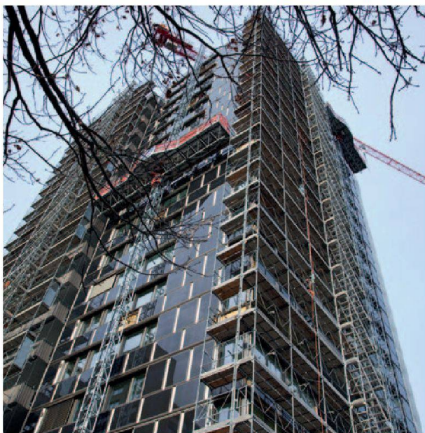
La nouvelle façade solaire et ses nouveaux balcons.
