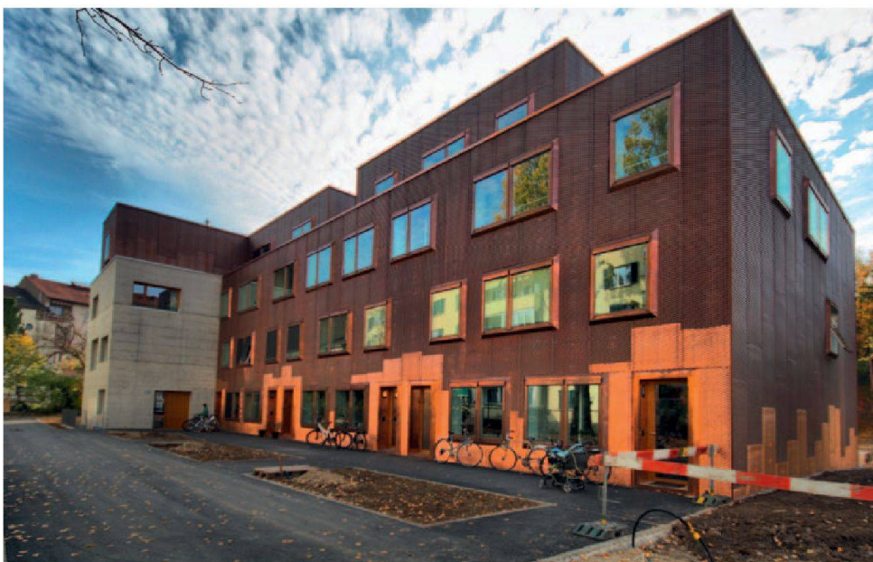
L'élégante alternance béton/cuivre de l'immeuble en T, côté cour.
