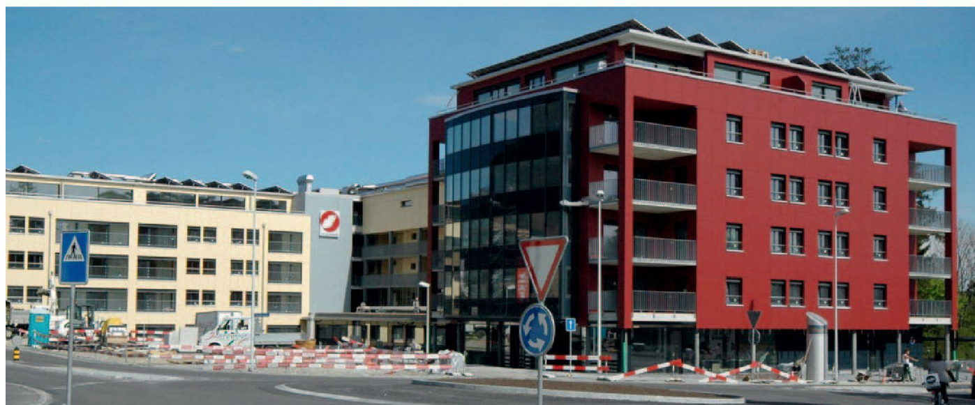
Vue d'ensemble des bâtiments en fin de construction. @ D. Ryhiner
