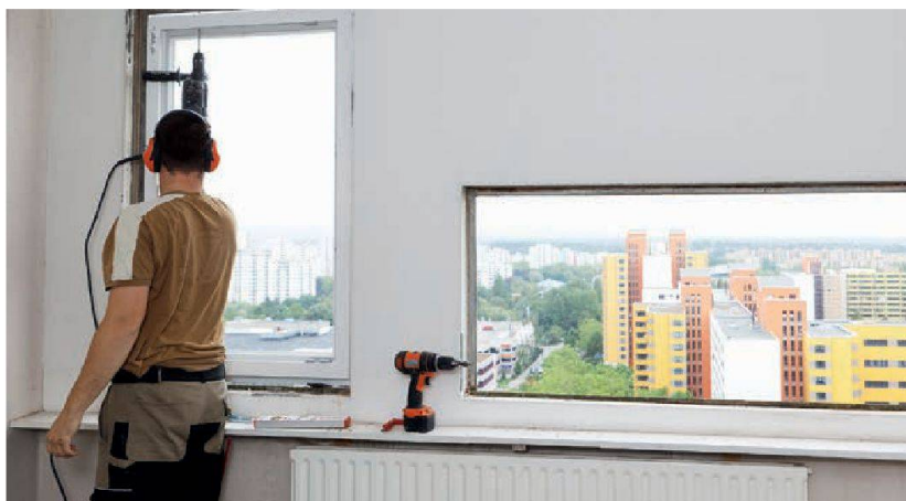
Les nouvelles fenêtres avec vitrage isolant. © Gesobau
