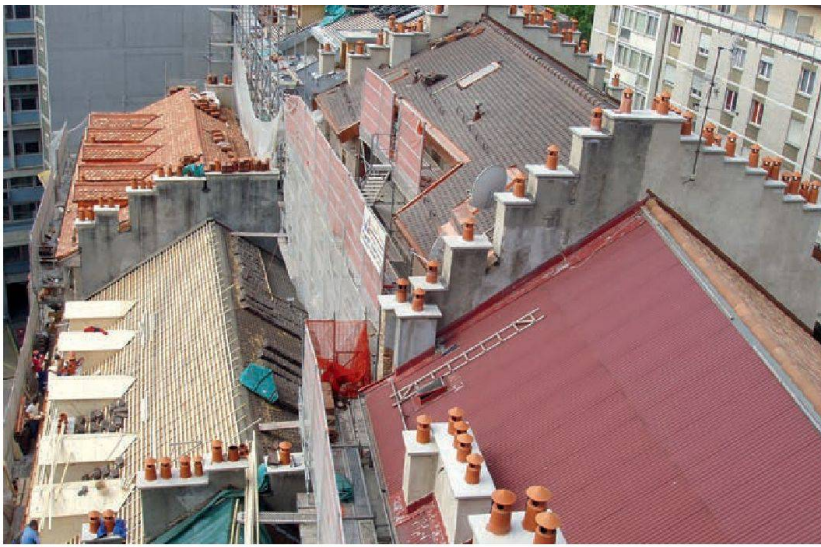
Les travaux sur les toits des immeubles mitoyens de la coopérative Tunnel-Riponne. Il n'a pas été nécessaire de changer les charpentes, qui ont en revanche été traitées. © Pont 12
