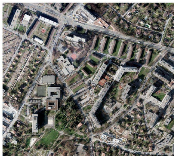
Le site aujourd'hui. Les bâtiments allongés dont le toit apparaît en beige seront démolis pour faire place au projet «Papillon».
