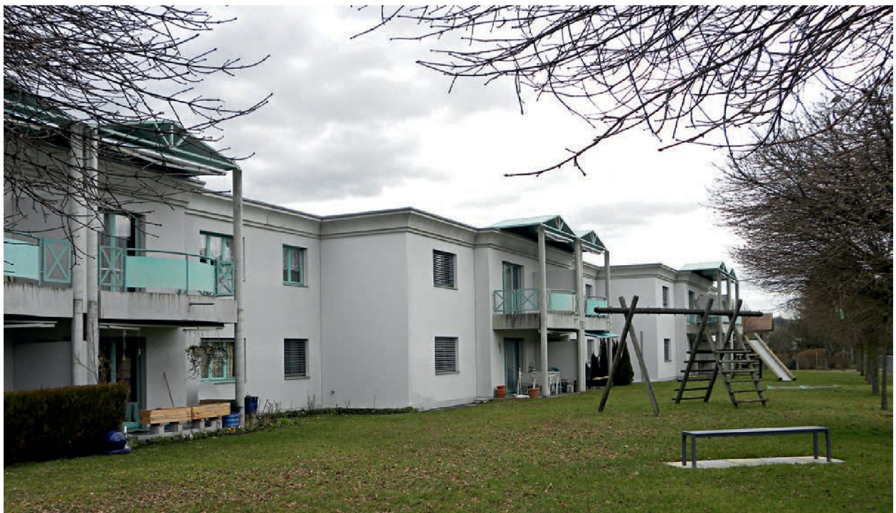
Façade sud de l'immeuble Chemin de Fougères 2. © JCP
