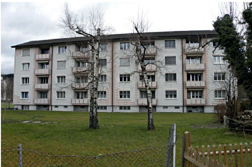
Façade sud de l'immeuble Chemin Longs Champs © JCP
