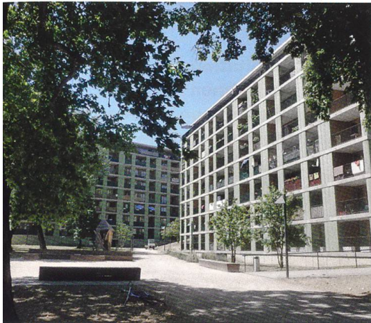
Première collaboration de la FVGLS et de la BAS, deux immeubles avenue de France (91 logements). © Borcard
