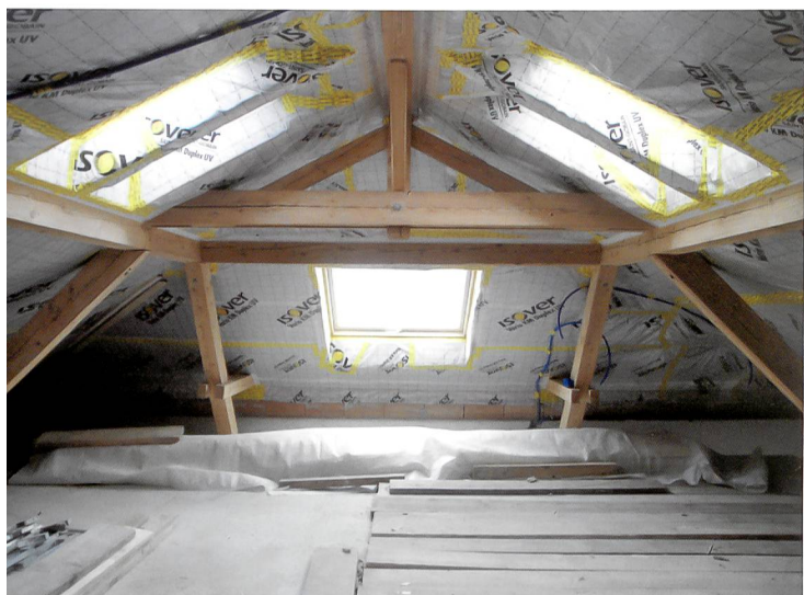
Les panneaux d'isolation sont fixés sous la charpente. © Lutz Architectes, Givisiez
