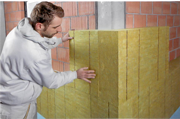
Pose des panneaux d'isolation contre un mur extérieur. © Flumroc
