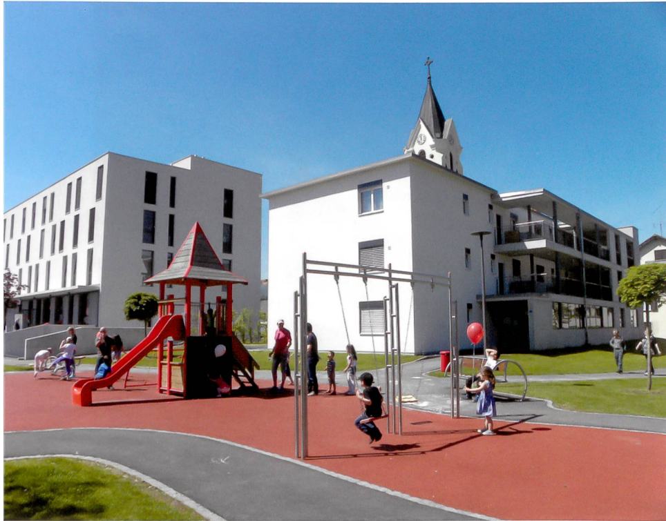
La dernière réalisation de la Société coopérative immobilière du Cartel syndical au cœur du village de Courroux. © J.-C. Prince
