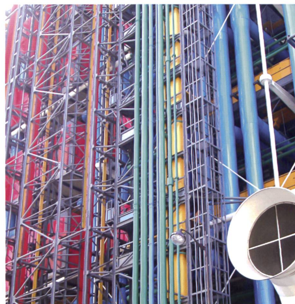
On dirait du BIM, mais non. C'est la façade extérieure du Centre Pompidou à Paris, qui fête cette année ses 40 ans. © photoeverywhere.co.uk
