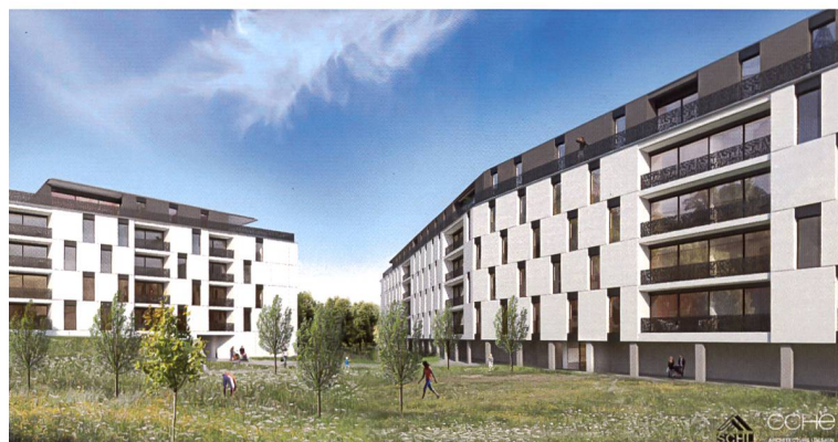
Image de synthèse d'un bâtiment du quartier de Maillefer III à Lausanne que construit la SCHL et dont le chantier vient de commencer.
