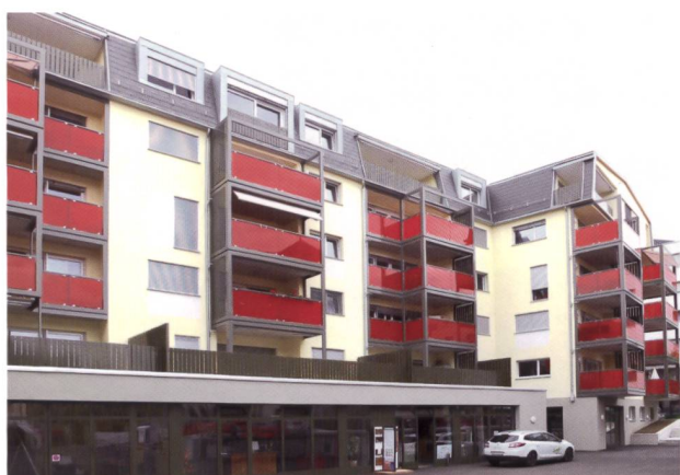
L'immeuble depuis la cour intérieure. © PC2017
