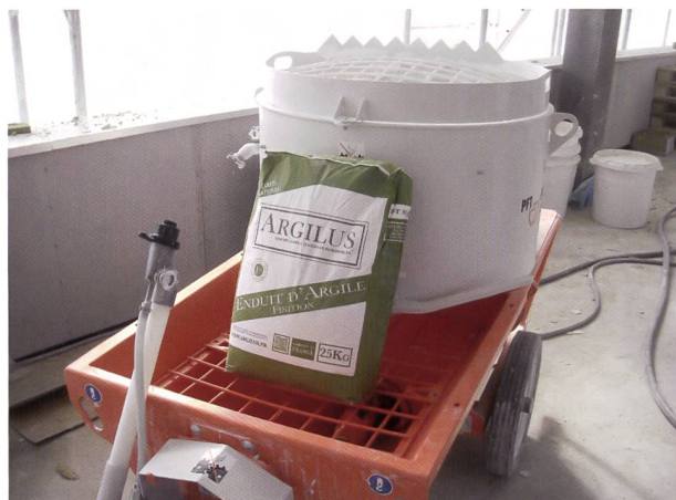
Le sac d'Argilus, la machine-malaxeuse, le tuyau d'eau et le tuyau-lance. © JLE
