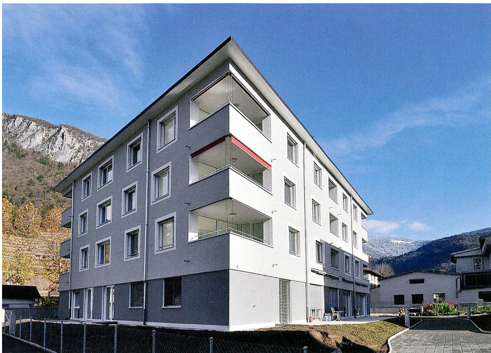
Trois immeubles Minergie (logements protégés) du site Campagne Emmanuel à Aigle. DR
