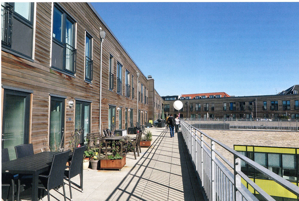
Le nouveau quartier de Måløv comprend un large mix de types de logements: coopératifs, en propriété et des communautés de seniors et d'unités de soins. © Franz Horváth
