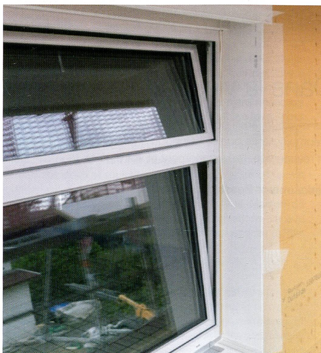
Le système Implio de raccord de fenêtre étanche au vent et à la pluie battante offre l'avantage de réaliser le raccord de fenêtre avec bandeau (panneau de linteau), caisson de volet roulant et/ou de store à lamelles et panneau d'habillage Rivestio ainsi que panneau d'embrasure et en biseau comme deuxième niveau d'étanchéité directement lors de la pose de l'isolation.
