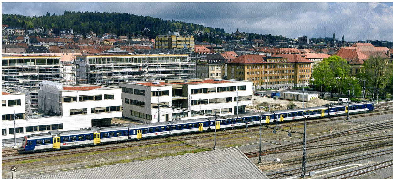
Quartier Durable du Corbusier à La Chaux-de-Fonds durant la construction du premier îlot... la suite reste à inventer!
