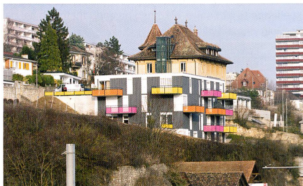
Les nouveaux appartements avec encadrement et leurs balcons colorés aux Vignes du Clos, à Serrières.
