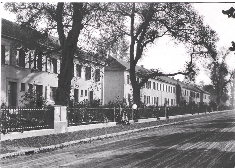
Une des premières réalisations de la SCHG, dans les années 20, au chemin des Sports. DR
