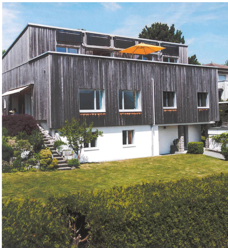
Les isolations de la façade (murs extérieurs) et du toit sont les rénovations prioritaires que le Programme Bâtiments finance par ses subventions. DR/© Fluxif (Gerry Nitsch) – Programme Bâtiments
