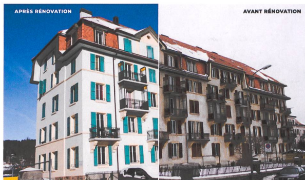
La coopérative de La Renouveau: rénovation complète au label Minergie, qui respecte le patrimoine UNESCO.
