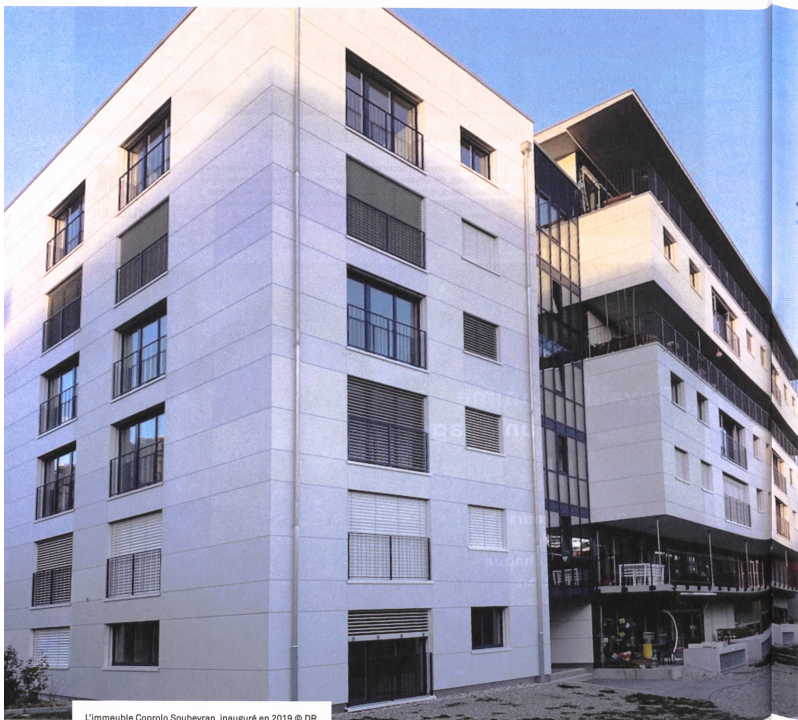
L'immeuble Coprolo Soubeyran, inauguré en 2019 © DR
