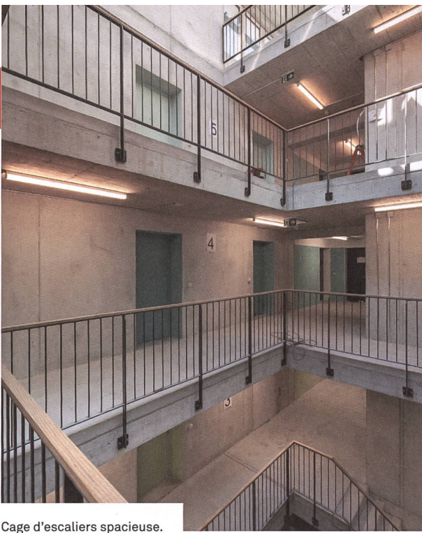
Cage d'escaliers spacieuse.
