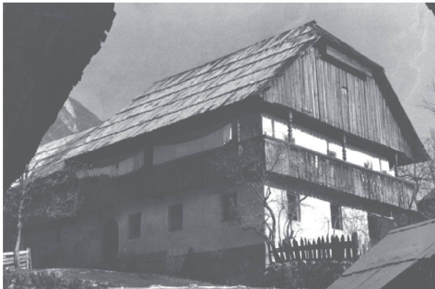
Bauernhaus in Stara Fužina in Bohinj (Photo: H. Ložar-Podlogar, 1975).
