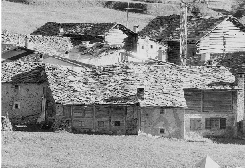
Ill. 5: Valnontey (Cogne). À l'avant plan, grande maison pour deux familles. Ruraux à cohabitation en bois et petits volumes en pierre, les péra, avec cave, foyer et chambre à provisions superposés.
