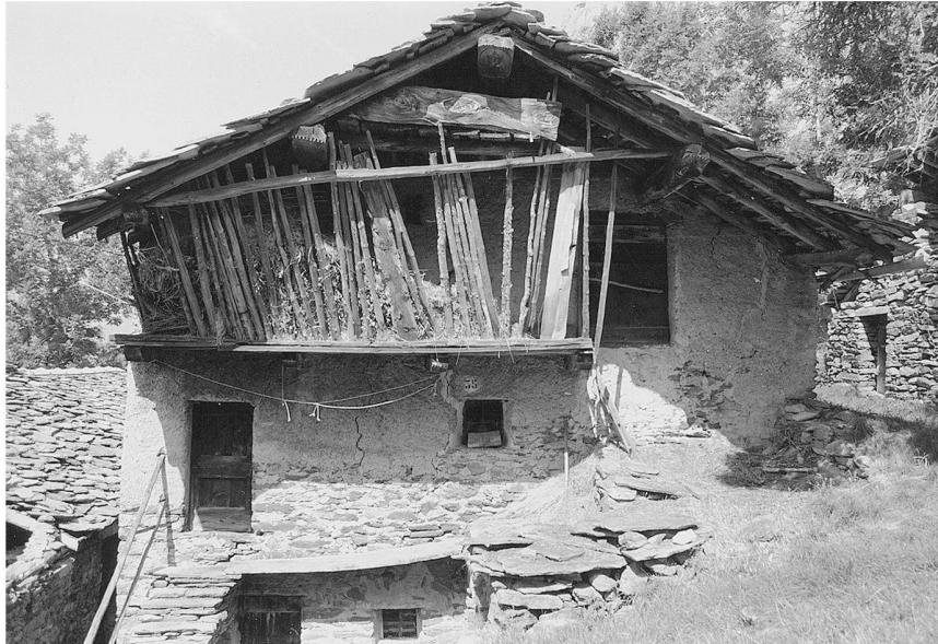
Ill. 3: Echallogne. Maison-bloc en hauteur de la seconde moitié du XIXe siècle. De bas en haut: étable, logis, fenil. Distribution entre les différents étages par l'extérieur.
