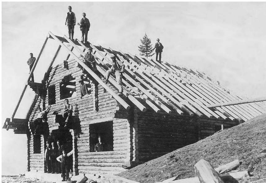
Abb. 3: Bau der Gafadurahütte, Richtfest um 1926. Liechtensteinisches Landesarchiv P-116/2/3, Original in Privatbesitz.
