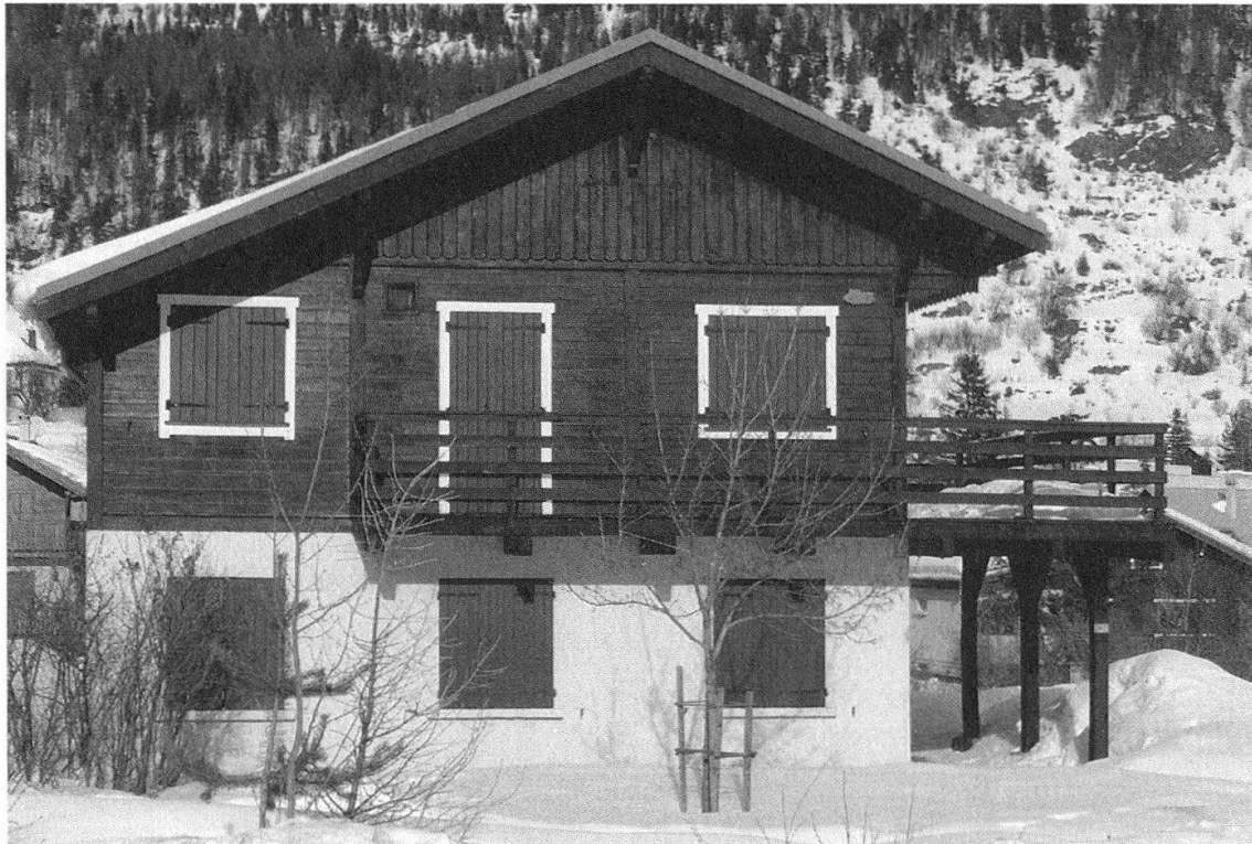
Fig. 5: Un chalet «typique» (fin des années 1960, vallée de Névache): soubassement en dur, structure principale en bois e volets peints de couleurs vives. Source: Cliché A.-M. Granet-Abisset, janvier 2010.
