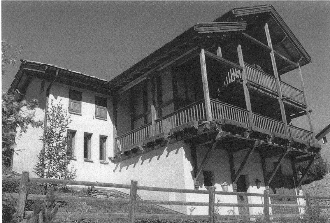
Fig. 6: Chalets des années 2000, Saint Véran (les nouvelles «fustes»). Source: Cliché A.-M. Granet-Abisset, 2008.
