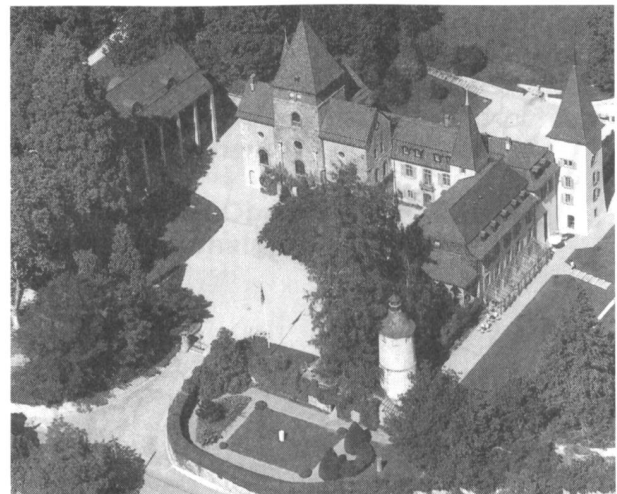
Alle Aufnahmen: Hochbauamt des Kantons Bern
