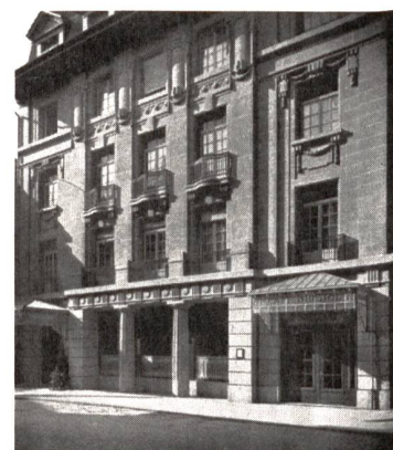
Hotel Bristol, Schauplatz- gasse 8–10. Städtisches Grosshotel von 1912. (Fotos aus: Albert Gerster, Architekt S.I.A., Bern. Aus- geführte Bauten , Zürich 1926)
