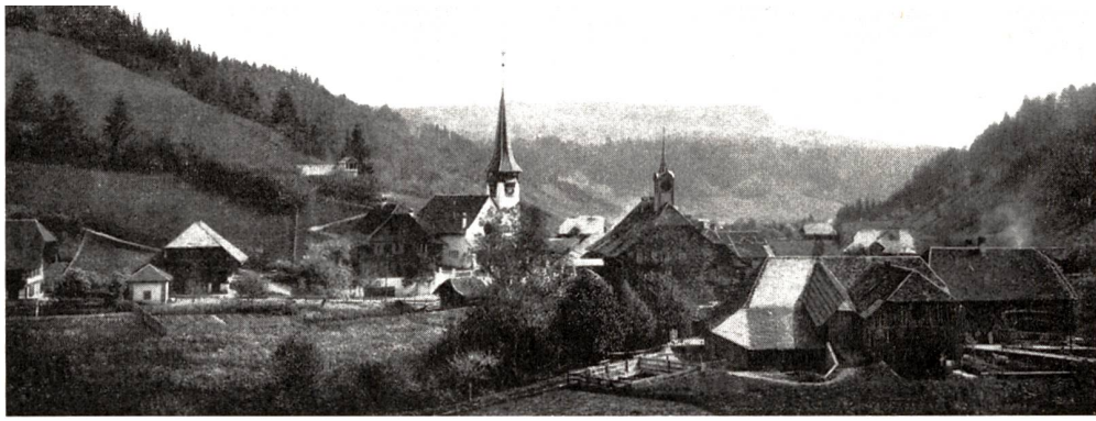
«Die Kirche in Röthenbach im Emmental (Kt. Bern) als Beispiel eines neuen, und doch dem Landschafts- und Dorfbild harmonisch eingefügten Baues. Architekt: Karl Indermühle, Bern.» (Heimatschutz, Januar 1907)
