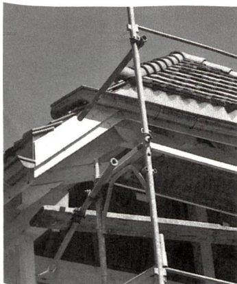
Detail eines neuen Daches. (Fotos: Peter Tanner)
