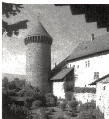
Une tour d'angle du château de Chenaux (XVe siècle). (Fotos: Service des biens culturels du Canton de Fribourg)
