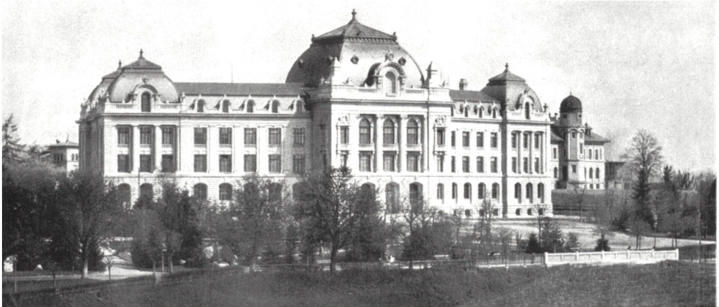
Hauptgebäude, Ansicht von Südwesten
