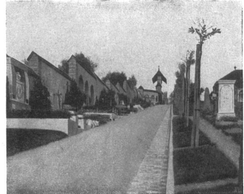
PARTIE VON DER UMFASSUNGSMAUER DES NEUEN FRIEDHOFES «ENZENBÜHL» in Zürich MUR D'ENCEINTE DU CIMETIÈRE ENZENBÜHL à Zurich
